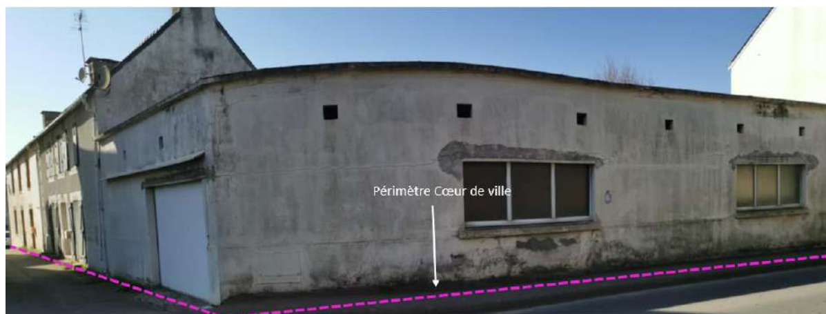
Photo 21 : garage en location et habitations rue Marc Mouélo
