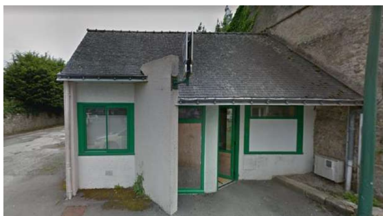
Photo 22 : WC public rue Febvrier Despointes
