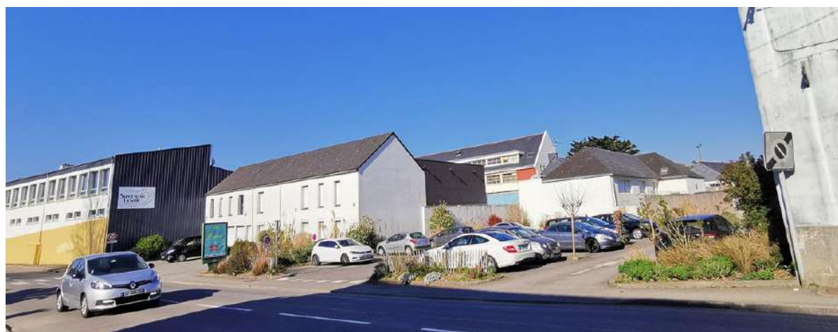
Photo 23 : vue sur le collège et le parking attenant depuis rue Saint-Maurice
