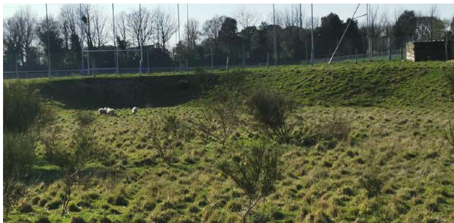
Photo 1 : bassin de régulation eaux pluviales (et terrain de rugby en arrière-plan)
